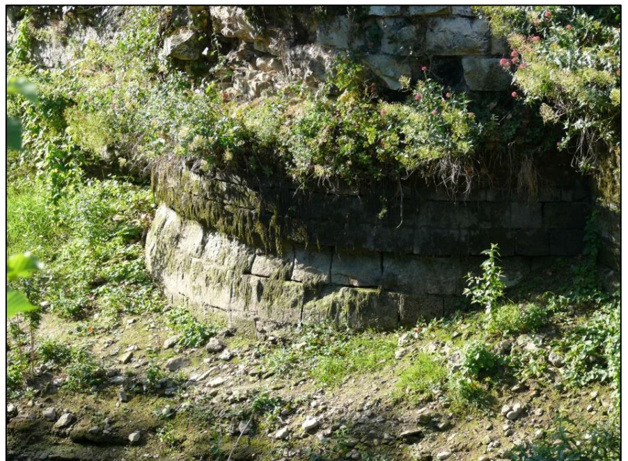
Les soubassements des tours de défense de la Porte de l'Île – Photo : Louis CAZAUBON – 14.06.2022.
